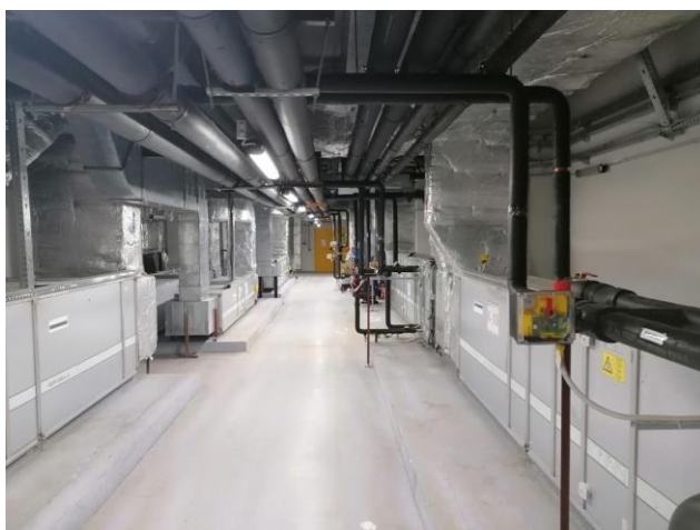
Фото 15. 5-ый этаж (технический)
