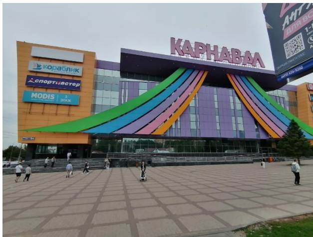
Фото 1. Внешний вид здания
