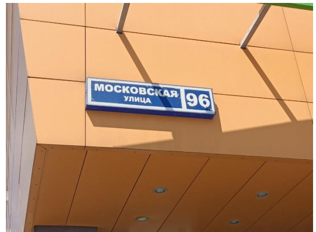
Фото 2. Внешний вид здания
