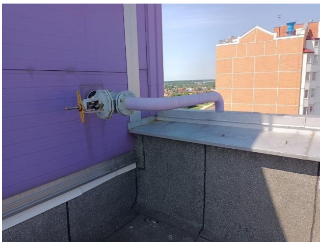
Фото 21. Газопровод-ввод
